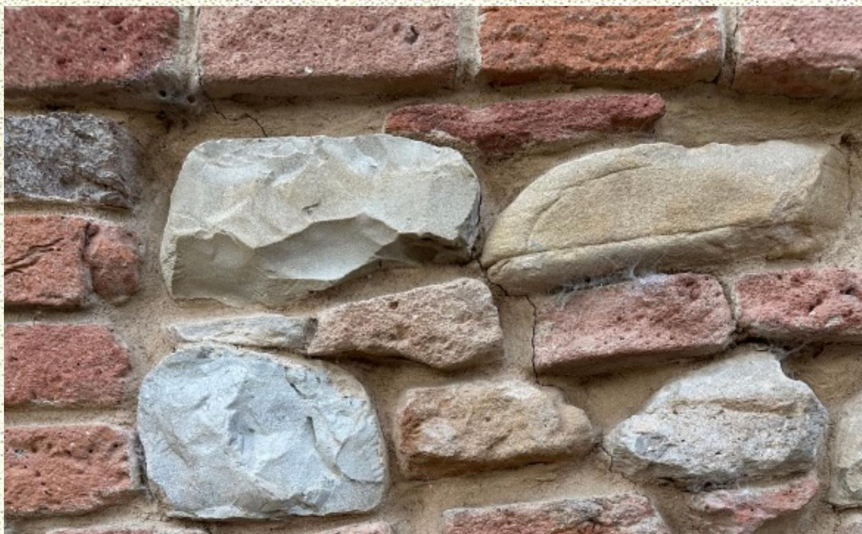
Dozza, via Calanco. Esempio di antica muratura in laterizio con inserti di ciottoli calcarei del Cretaceo a frattura concoide e di arenaria dura (macigno) dell'appennino a monte del torrente Sellustra.
